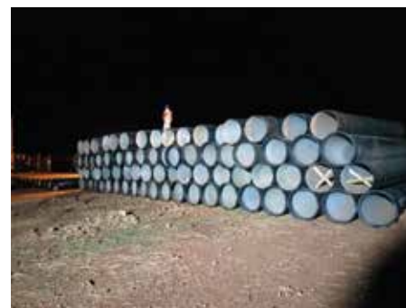
Stockage de conduites FD DN 600, 700 et 1000/PAEP Bamako-Kabala/ Mali/2018-2021
