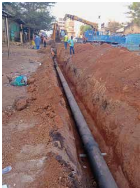
Pose de canalisation en FD DN300/PAEP Bamako-Kabala/ Mali/2018-2021
