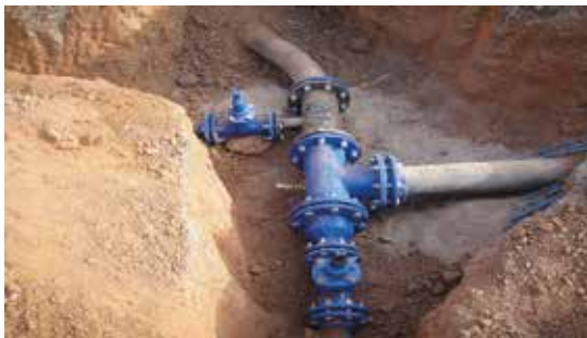
Pose de pièces de raccordement/AEP Diebougou Burkina Faso/2012-2013
