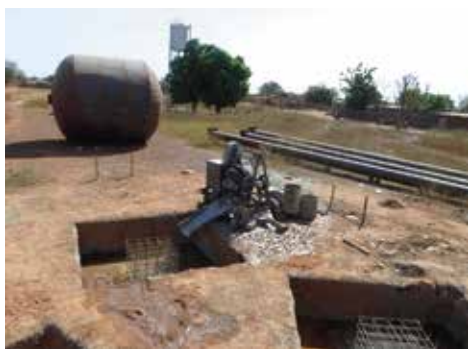
Cuve et poteaux d'un château d'eau de 150m 3 /AEP Solenzo Burkina Faso/2013-2015
