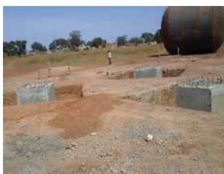
Semelles d'un château d'eau de 150m 3 /AEP Solenzo Burkina Faso/2013-2015
