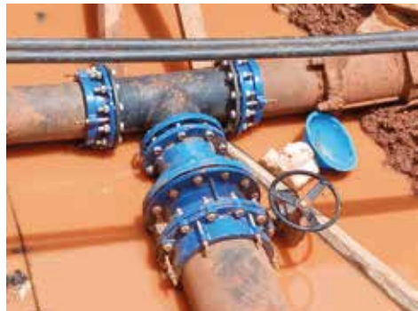
Pièces de raccordement /PAEP Bamako-Kabala/ Mali/2018-2021
