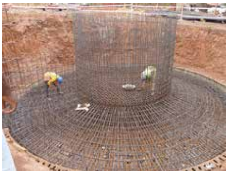
Ferrailage d'un château de 500m3 /PAEP Bamako-Kabala/ Mali/2018-2021
