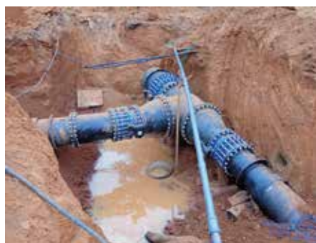
Raccordement FD DN 600, 700 et 1000/PAEP Bamako-Kabala/ Mali/2018-2021
