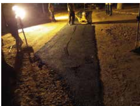
Refection de bitumes /PAEP Bamako-Kabala/ Mali/2018-2021
