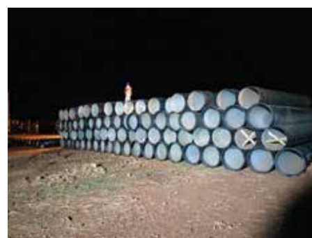
Stockage de conduites FD DN 600, 700 et 1000/PAEP Bamako-Kabala/ Mali/2018-2021
