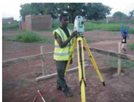
Implantation d'un château d'eau de 150m 3 /AEP Solenzo Burkina Faso/2013-2015
