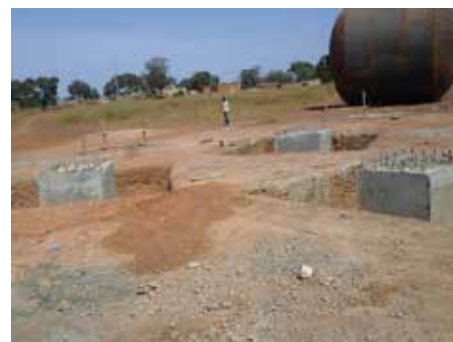
Semelles d'un château d'eau de 150m 3 /AEP Solenzo Burkina Faso/2013-2015
