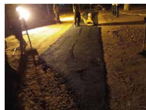
Refection de bitumes /PAEP Bamako-Kabala/ Mali/2018-2021
