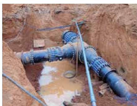
Raccordement FD DN 600, 700 et 1000/PAEP Bamako-Kabala/ Mali/2018-2021
