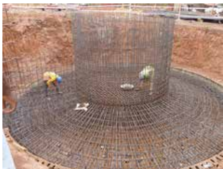
Ferraillage d'un château de 500m 3 /PAEP Bamako-Kabala/ Mali/2018-2021
